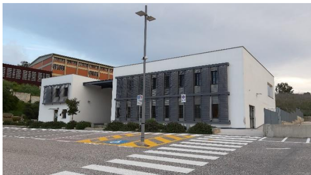
Foto 11 – vista uffici e parcheggio
