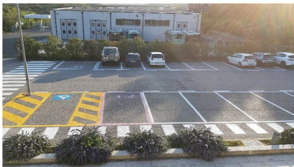
Foto 10 – vista officina e parcheggio
