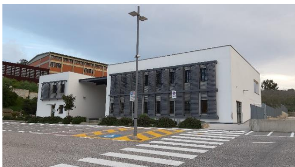
Foto 9 – vista uffici e parcheggio
