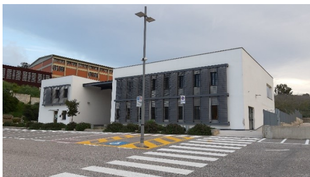
Foto 9 – vista uffici e parcheggio
