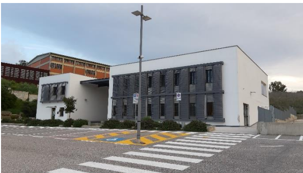
Foto 9 – vista uffici e parcheggio
