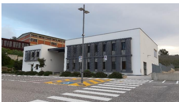
Foto 9 – vista uffici e parcheggio
